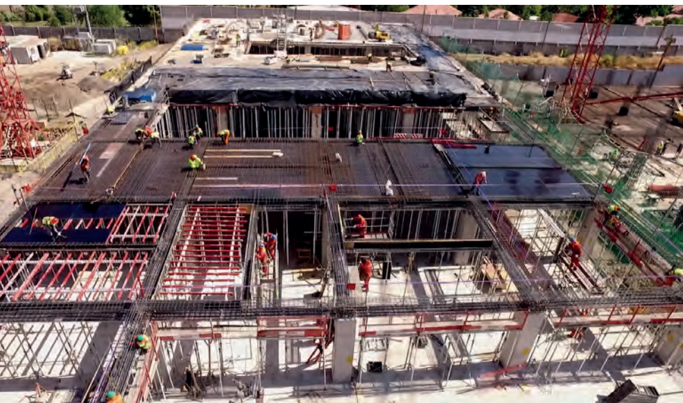
La Viga de Cuelgue Modular es un sistema que permite recuperar hasta el 80% del equipo, luego de 72 horas de haber hormigonado.
