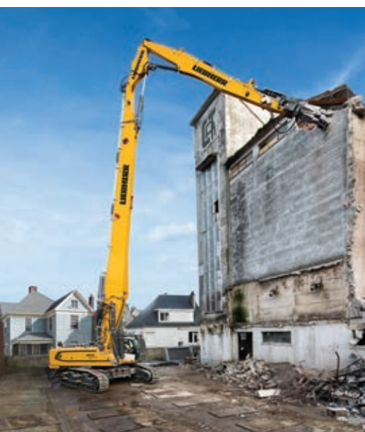
A escavadeira de demolição da Liebherr R 960 recebeu premiações e reconhecimentos por sua capacidade e sistema de controle.
