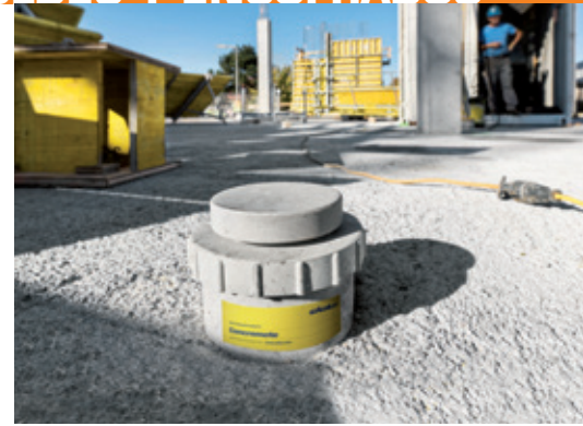
El sistema de sensores Concremate, que permite controlar y agilizar el proceso de desmolde, es una de las novedades de DOKA.
