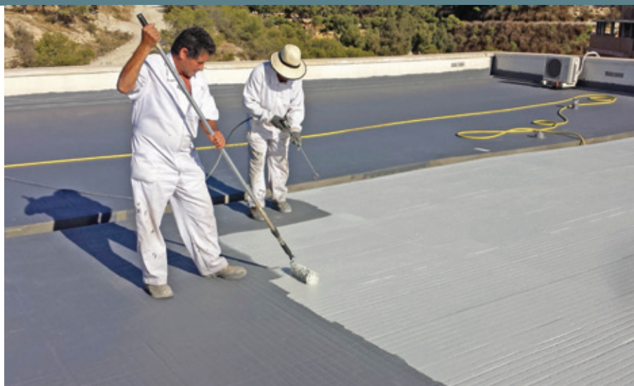
Los productos a utilizar en la impermeabilización depende de factores como en qué sustrato se aplicará, la zona geográfica, resistencias mecánicas, etc.
