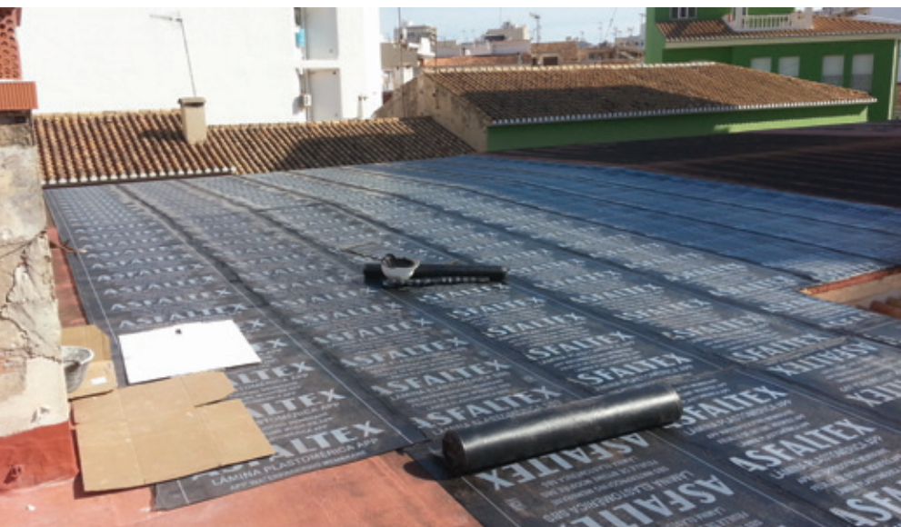
Impermeabilización con tela asfáltica.
