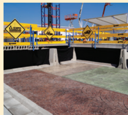
Innovación en pisos de concreto fue uno de los aspectos tomados en cuenta por Expo Hormigón.
