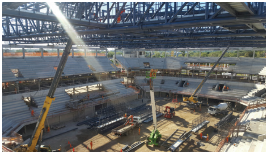
El sistema Mesa Multiform, de Alsina, permitió la construcción de este estadio en Uruguay sin utilizar puntales individuales.
