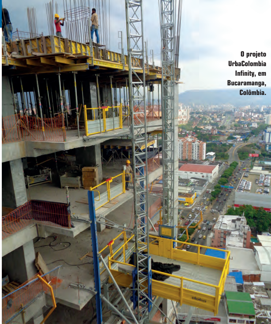
O TG60 da Layher tem pré-montagem a partir do chão na horizontal, para então montar a torre de cimbramento.
